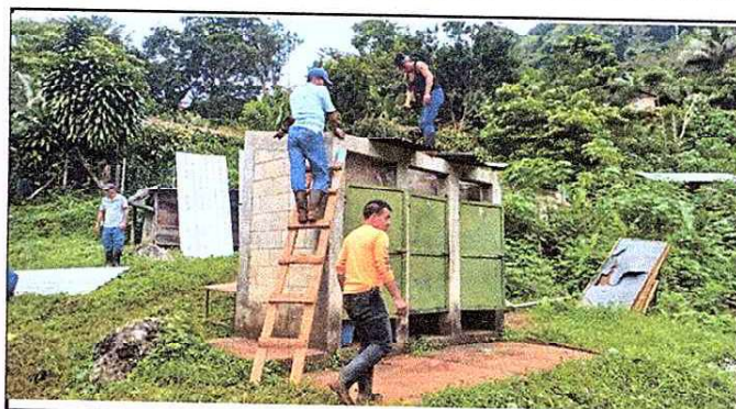
Foto 4: DANDO MANTENIMIENTOS DE BAÑOS
