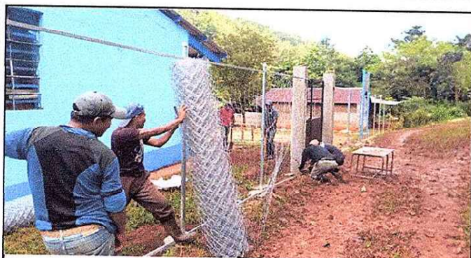
Foto 3: SUSTITUYENDO MALLA INSERVIBLE Y POSTES PODRIDOS POR MALLAS NUEVAS Y TUBOS GALVANIZADOS
