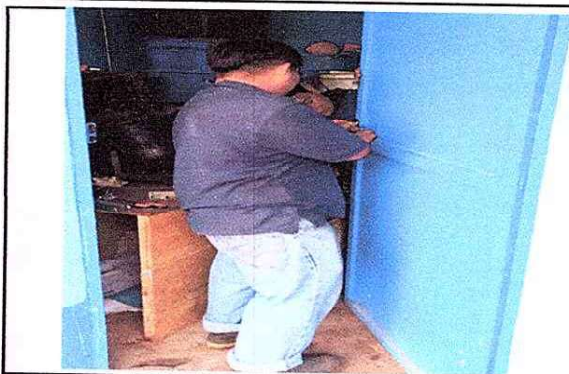
Foto 2: SUSTITUYENDO CHAPA DE PUERTA
