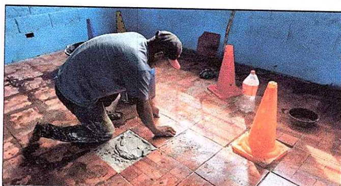
Foto 6: SUSTITUYENDO PISO CEMENTO LIQUIDO POR PISO CERAMICO
