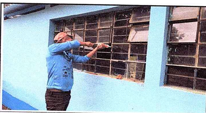
Foto 5: SUSTITUYENDO VIDRIOS EN MAL ESTADO EN AULAS
