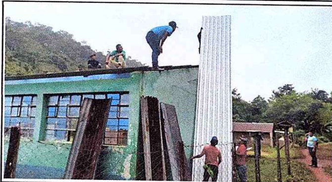
Foto1: SUSTITUYENDO LAMINAS EN AULAS
